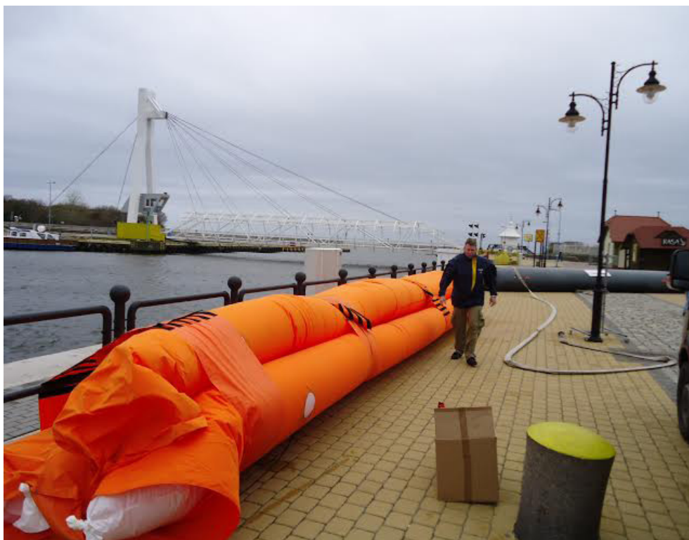
Fot. 1. Zapory wypełniane wodą produkcji firmy „Bielawa”, fot. S. Dzedzianowicz.
